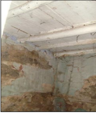
سقف إحدى الغرف
